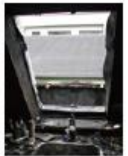
【アルミサッシ】 枠・框は溶け落ちています。
